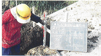
▲掘削深の確認
