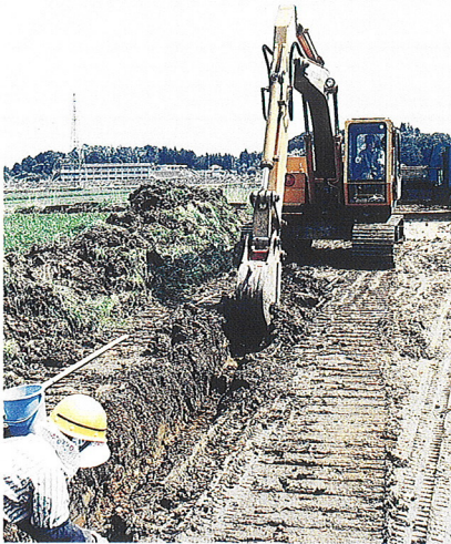
▲レベルを測定しながら掘削
