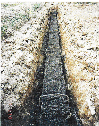
▲碎石の上に荒目砂を投入
