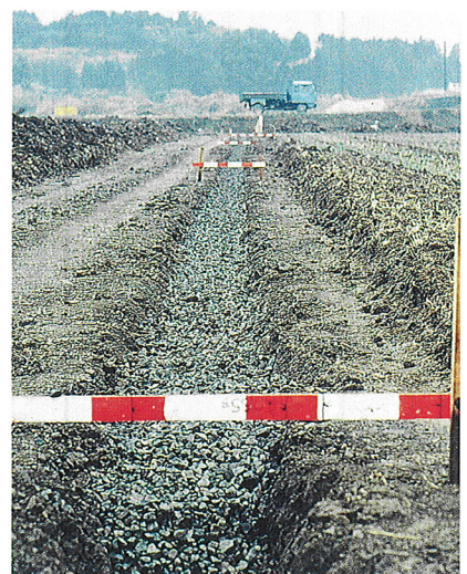
▲被覆材はまず碎石を投入
