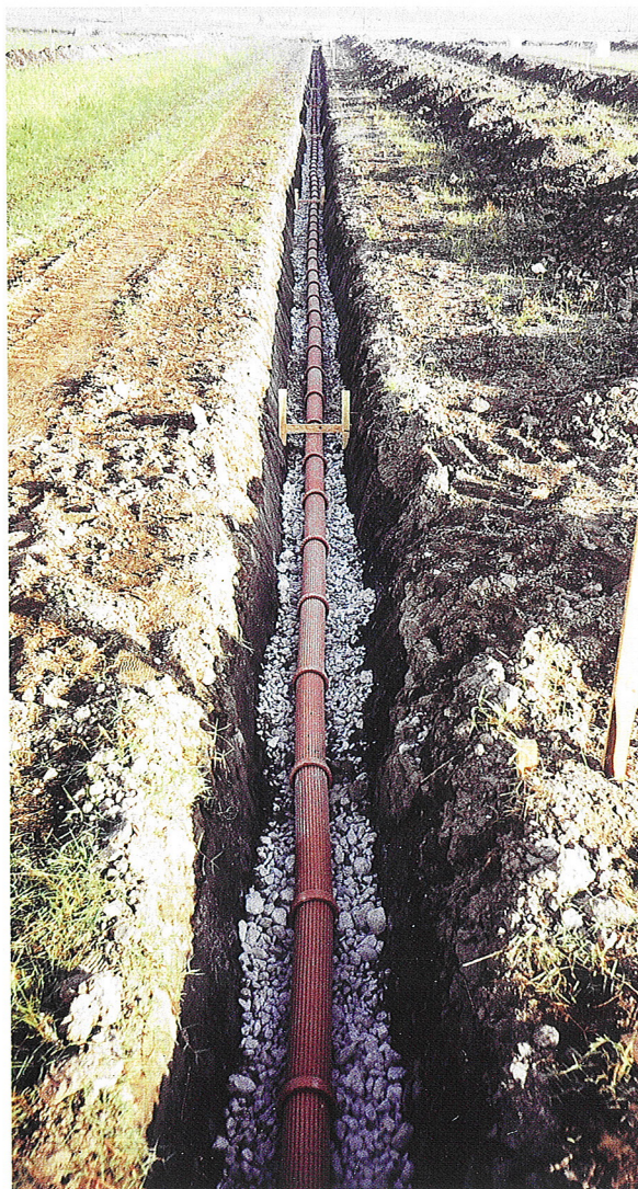
敷設されたストライプ土管
