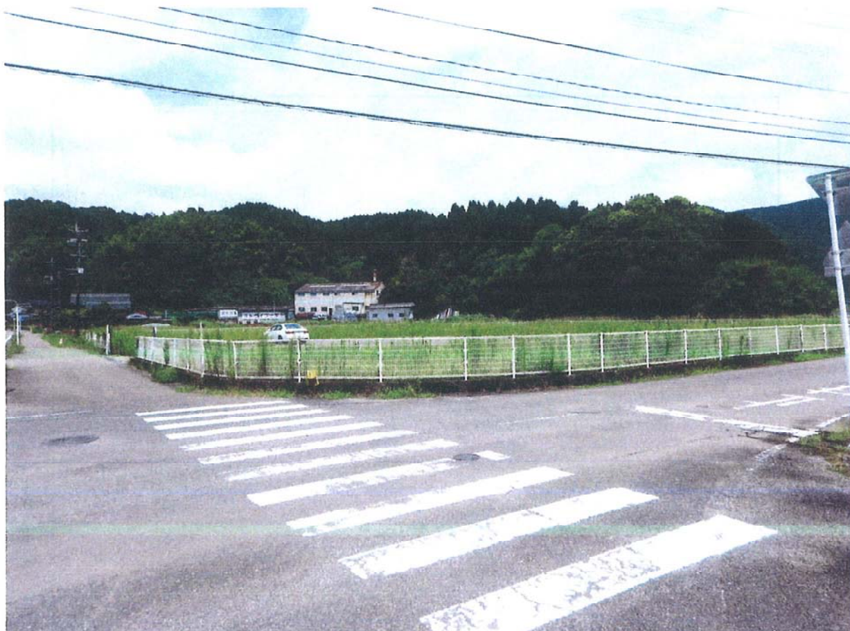
エントランス広場 現況
