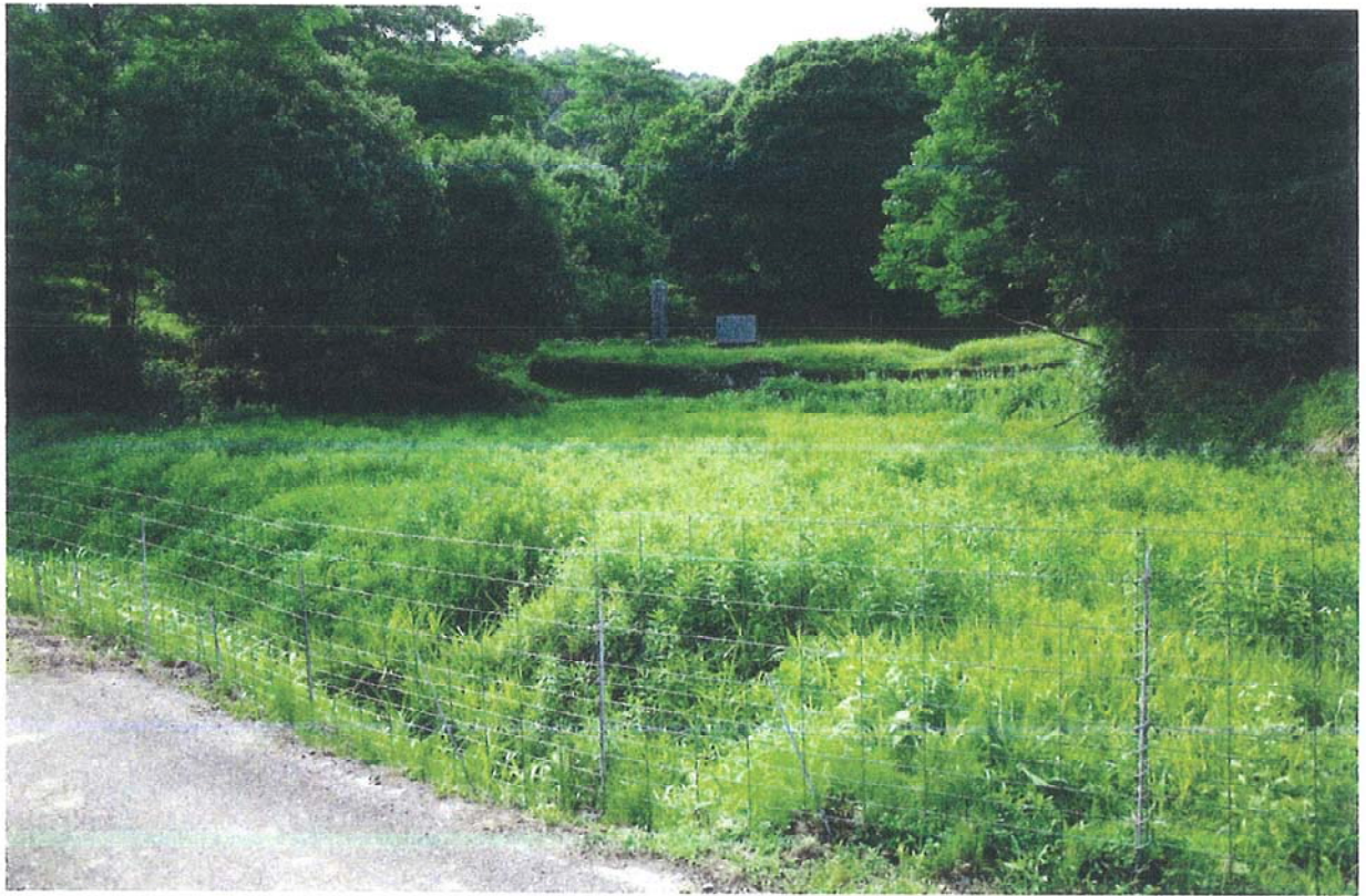
第1水門・南門 現況
