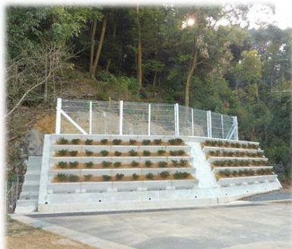
擁壁による法面の崩壊防止工事
