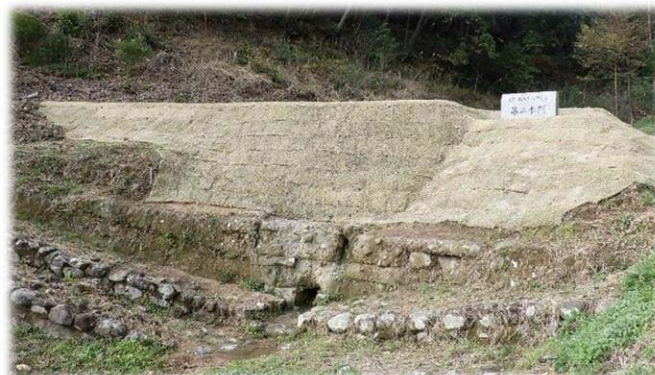
【第二水門】法面崩落を復旧しました
