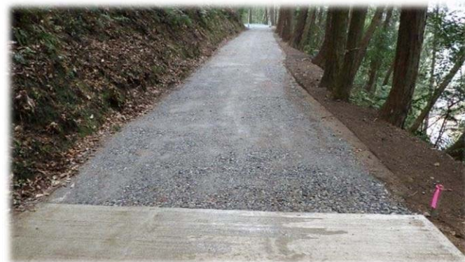
【園路】碎石舗装を行いました
