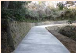
←コンクリート舗装
