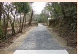
←グラウンドセル砕石舗装
