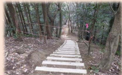
↑整備後(園路7)木製階段設置
