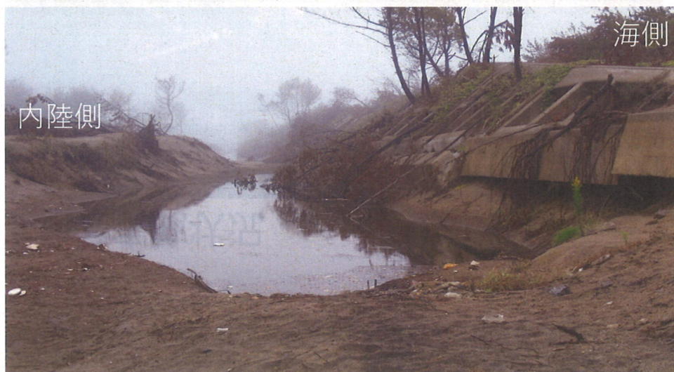
東日本大地震 仙台南部海岸三面張護岸被災（平成23年10月22日撮影）
